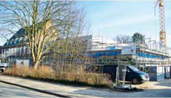
An der Brüder-Grimm-Schule geht es zügig voran, der Anbau sieht fast größer aus, als das Hauptgebäude
